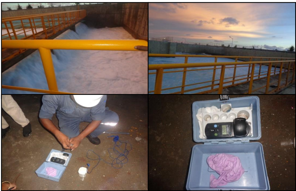
රූප සටහන අංක 14- පිරිපහදු කිරීමෙන් පසු ජලය මුහුදට මුදා හැරීම හා එම ජලයේ ගුණත්වය පරීක්ෂා කිරීම
