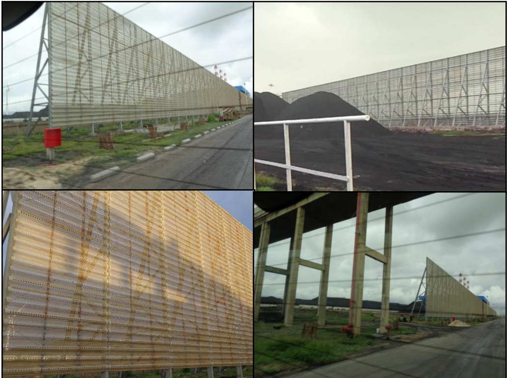
රූප සටහන අංක 09 - ගල් අඟුරු අංගනය වටා ඇති සුළං බාධකය
