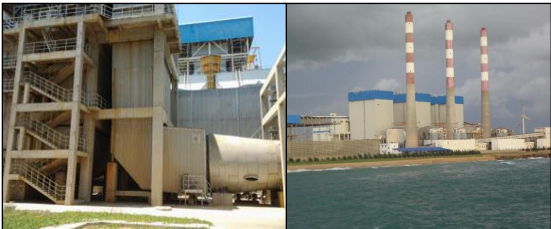
රූප සටහන අංක 07 - විමෝචක වායු ගෙන්දගම් වියුක්තකය සහ ඒකක තුනට අදාල විමිනි
